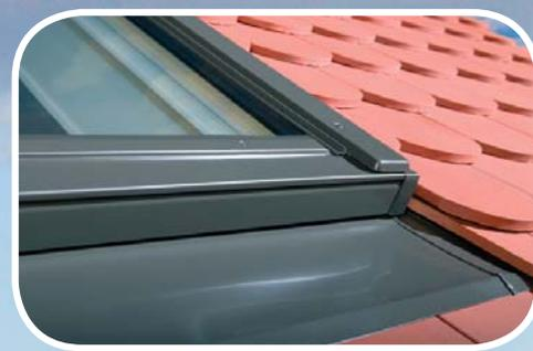
Desde el exterior la ventana está protegida con perfiles extrusionados de chapa de aluminio con una capa de poliéster modificado en color gris-marrón resistente a los factores atmosféricos y los rayos UV.
